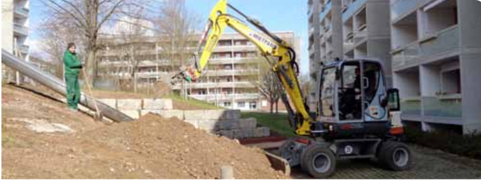
Steffen Bamberg (Schaufel) und Thomas Müller (im Bagger) von der Firma Landschaftsbau Erfurt im Arbeitseinsatz. Foto: Meß
