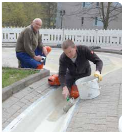
Inzwischen sind die Gerüste entfernt: Andreas und Peter Erfurth haben die restliche Wasserrinne saniert und die Oberfläche versiegelt. Einer Wiederinbetriebnahme der Wasserrinne sollte nichts mehr im Wege stehen. Foto: Mehlich
