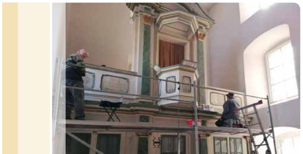
Die Emporenmalerei in der Kirche Winzerla erstrahlt in neuem Glanz: Jürgen Seifert und Michael Matz von der Firma Michael Matz und Partner aus Weimar haben neun Bildmotive fachgerecht gereinigt und restauriert. Für die Arbeiten an der Altarwand und am Kanzelkorb wurden etwa 100 Arbeitsstunden benötigt, die Gesamtkosten liegen bei 4.000 Euro. Foto: MeB
