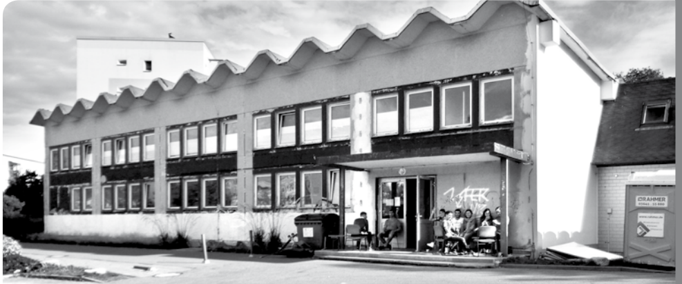
Notquartier auf unbestimmte Zeit: die alte Turnhalle in der Schrödingerstraße. Foto: Meß
