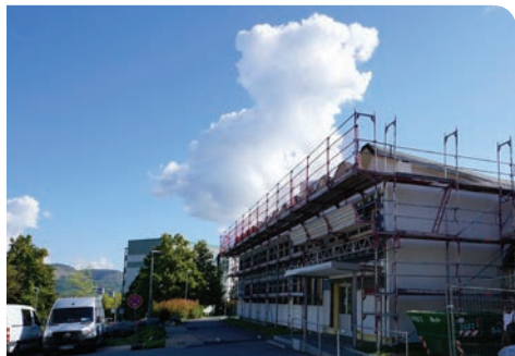
Fleißig gearbeitet wird derzeit an der Turnhalle in der Schrödingerstraße. Foto: Laudien
