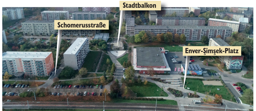
Das Drohnenbild zeigt das Areal, auf dem das neue Bürgerzentrum entstehen soll.
