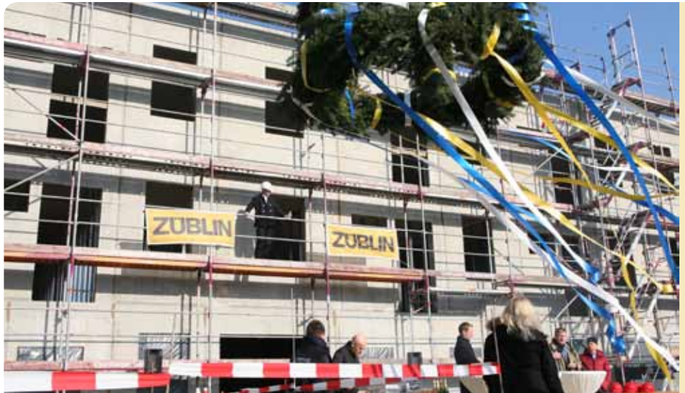
Bei strahlendem Sonnenschein wurde das Richtfest gefeiert. Foto: Laudien
