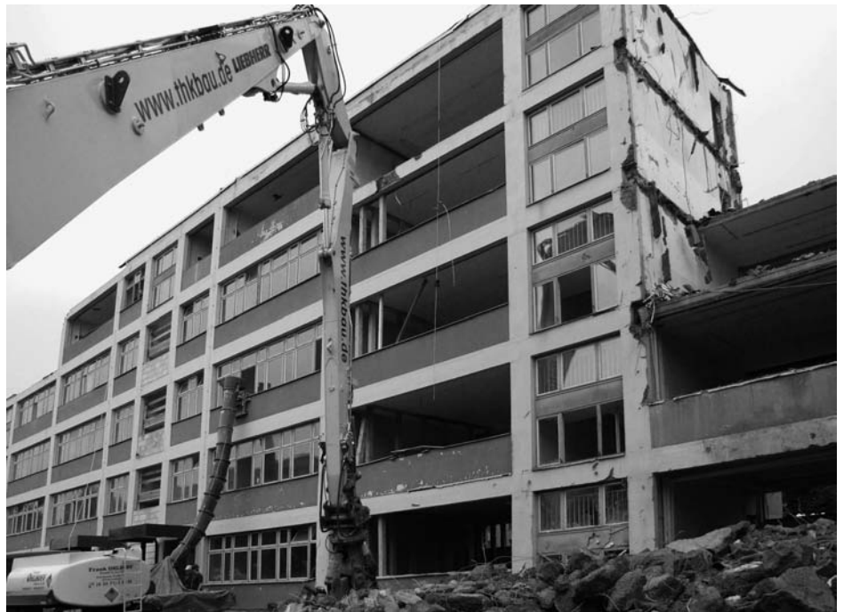
Platte für Platte - so wie das Gebäude aufgebaut wurde, wird es jetzt zum Teil wieder abgetragen, um neuen Anforderungen entsprechend saniert zu werden. (Foto: Meister)
