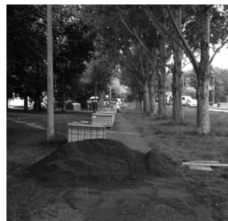
Die Wegebauarbeiten in der Bertolt-Brecht-Straße haben begonnen. (Foto: Mehlich)
