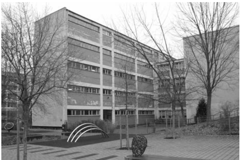
Blick auf die Schillerschule von der gegenüberliegenden Sporthalle aus. Am Vordergebäude (links) wird ein ganzer Riegel zurückgebaut, ebenso das gesamte Obergeschoss. Vom Zwischenbau (neuer Haupteingang) gelang man künftig auch in die dahinterliegende neue Aula. (Foto: Schorcht)
